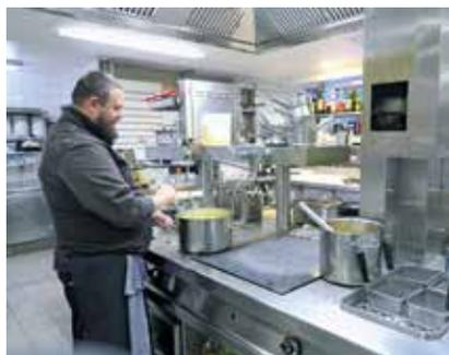
Vorteile auf mehreren Ebenen: In Gewerbeküchen kann einerseits die überschüssige Wärme der Warmwasserversorgung zugeführt werden und gleichzeitig die geringere Umgebungstemperatur die Arbeitsbedingungen verbessern. Eingesetzt ist hier Wärmerückgewinnung mit inkludierten Leitblechen des TurbuFlexS von Schröder.
