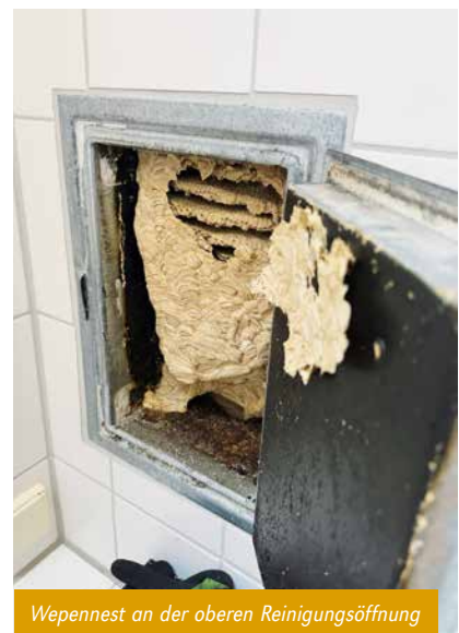
Wespennest zwischen einem Edelstahlinnenrohr und dem Reinigungsverschluss
