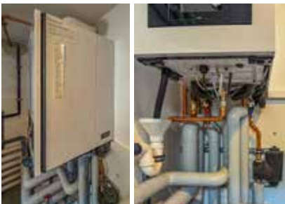
Die Schnittstelle Kit 65 wird an der Wand montiert, der Kessel bündig davorgehängt und damit verbunden. In rund einer halben Stunde ist die Gas-Heizung „hybrid ready“: Jetzt kann zu einem beliebigen Zeitpunkt die Wärmepumpe angeschlossen werden.
