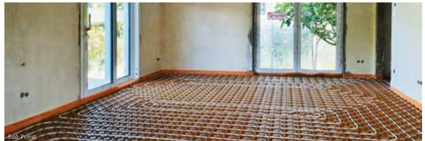
Die neue Fußbodenheizung im Erdgeschoss verbreitet jetzt auch bei niedrigen Vorlauftemperaturen gleichmäßige Behaglichkeit.
