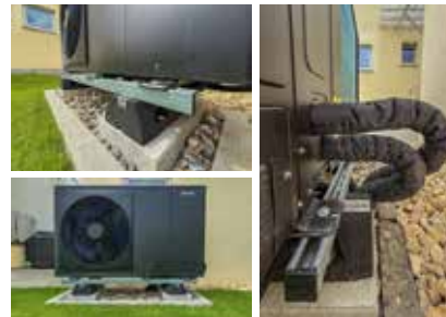
Auf dem schalldämmenden Gestell arbeitet die BLW Eco stabil und ruhig bei -25 bis +35 °C Umgebungstemperatur. Das Monoblock-Gerät ist vergleichsweise niedrig und wartungsfreundlich gebaut.
