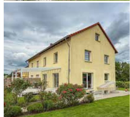
Im Lauf von fast 70 Jahren hat diese Doppelhaushälfte viele Umbauten erlebt, die bei der aktuellen Sanierung zu berücksichtigen waren.
