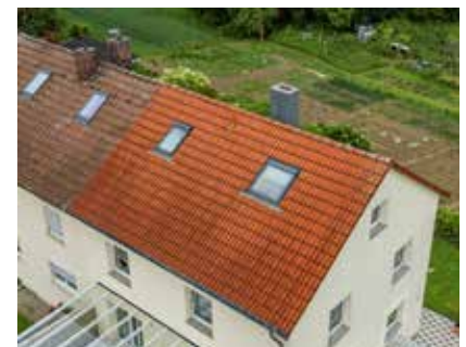
Den ca. 13 Meter hohen Schornstein der Doppelhaushälfte wieder freizulegen und zu erneuern erforderte besondere Anstrengungen.
