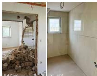
Während der aufwendigen Renovierungsarbeiten konnte die Familie auf die Wohnräume im Obergeschoss ausweichen.
